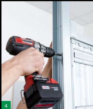
Připevnění pouzdra ke konstrukci SDK
