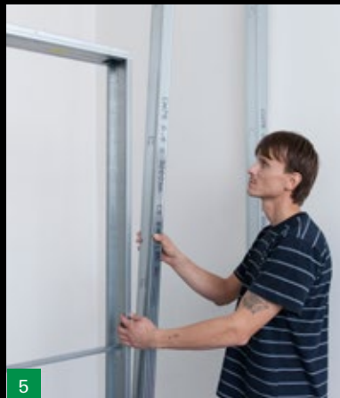
Montáž protilehlé strany SDK konstrukce
